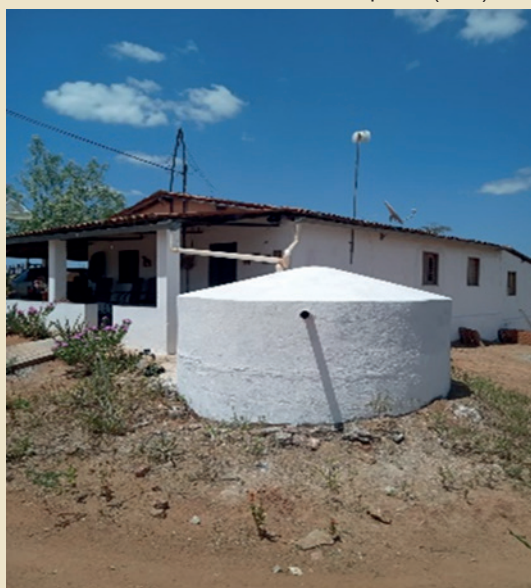
Figura 2 - Cisterna de placa na propriedade rural de Erinaldo Mesquita de Castro, em Senador Pompeu (CE).
